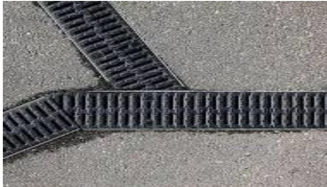
**Gambar 2. 5** Drainase Permukaan Tanah
