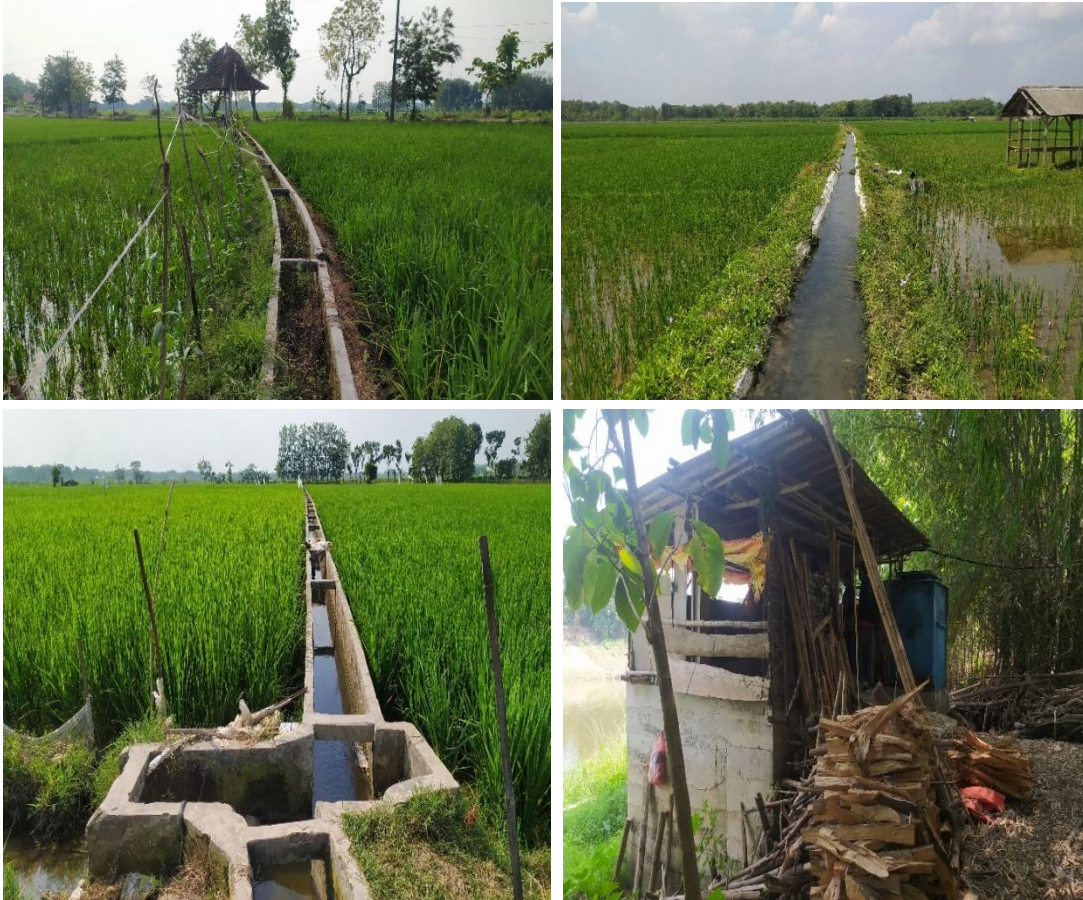
Gambar 1. Kondisi Jaringan Irigasi D.I. Sumberarum
