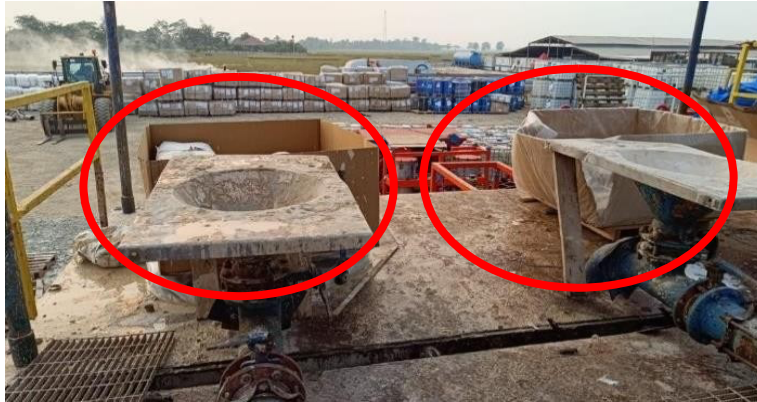
Gambar 2. Mixing Hooper (Tempat Meracik Aditif Chemical Bahan Lumpur Pemboran Sumur)
