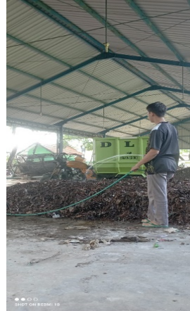
Gambar 3. Menyiram formulasi dan air ke tumpukan bahan baku
