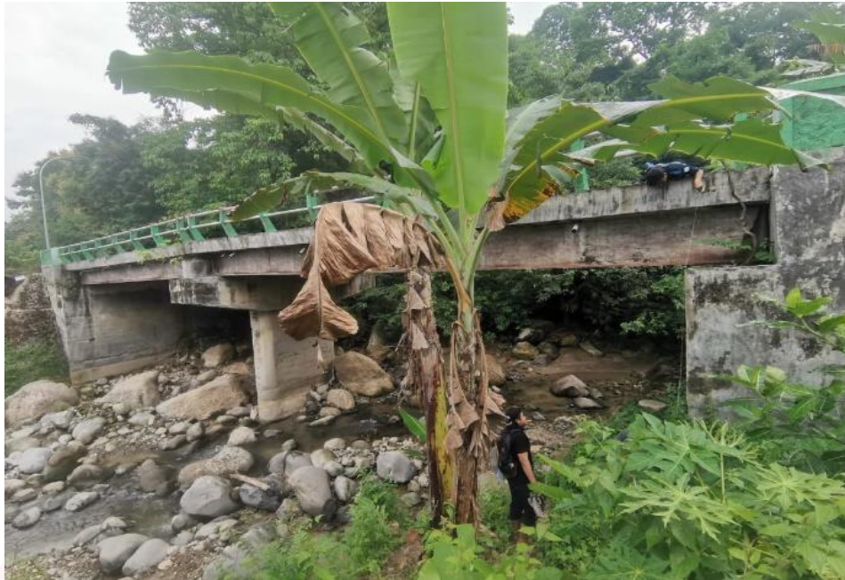
Gambar 1.3 : Kondisi Existing Jembatan Sumber : Dokumentasi Penulis.
