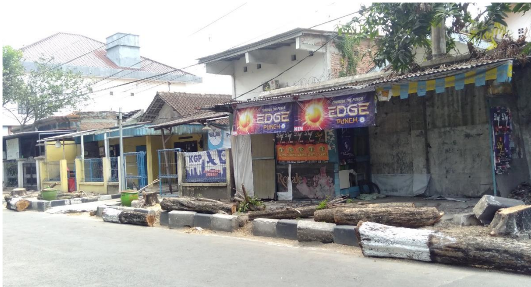
Proses Perbaikan Saluran Drainase yang Terletak di Jalan Basuki Rahmat. Hal Ini Mengakibatkan Ratusan Pohon Ditebang Habis Hingga ke Akarnya.
