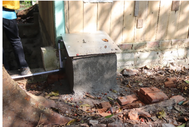
Gambar 5. Pembangunan Rumah Pompa Air
