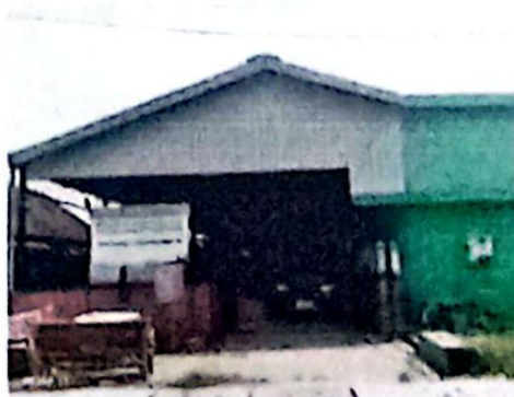
Gambar 4.7 Tempat Lokasi IPAL
