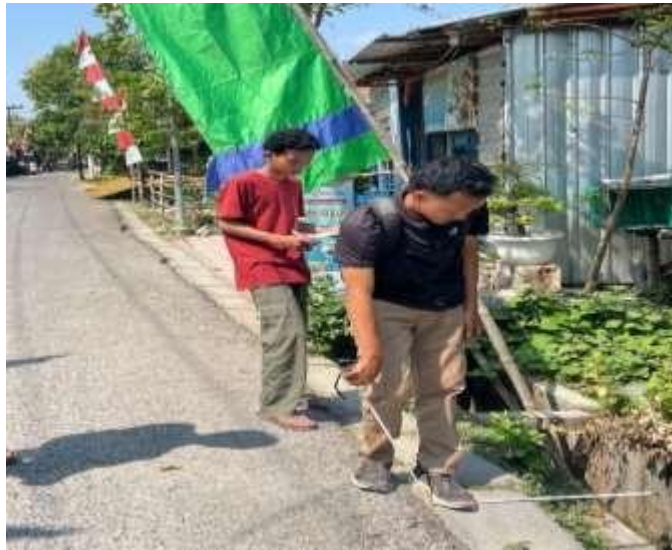
Gambar 3.28 Survei Bangunan Eksisting Saluran Drainase Desa Glaghwangi
