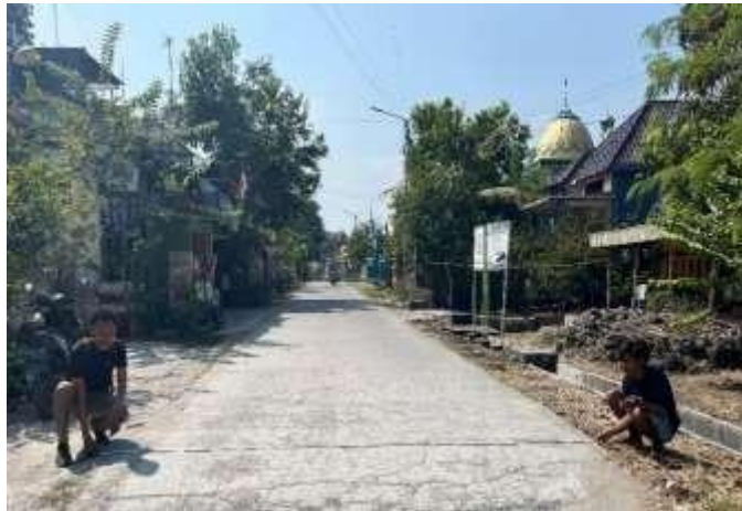
Gambar 3.26 Survei bangunan eksisting jalan cor desa glagahwangi
