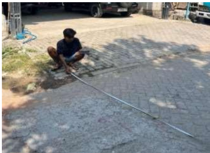
Gambar 3.27 Survei bangunan eksisting jalan paving desa Glagahwangi
