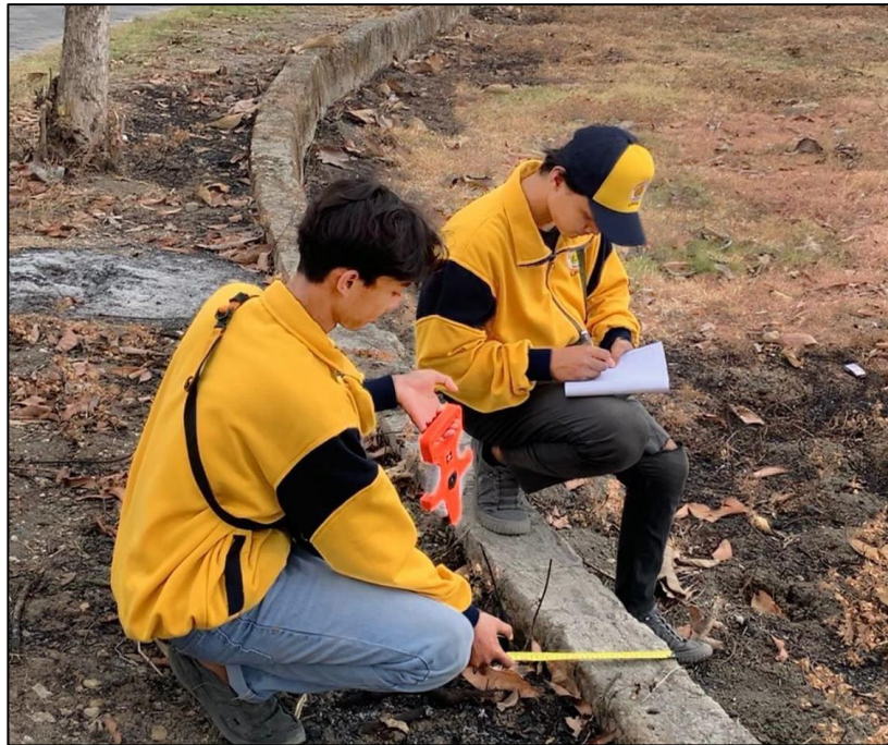
Gambar 3. 18 Survei Bangunan Eksisting TPT Desa Butoh
