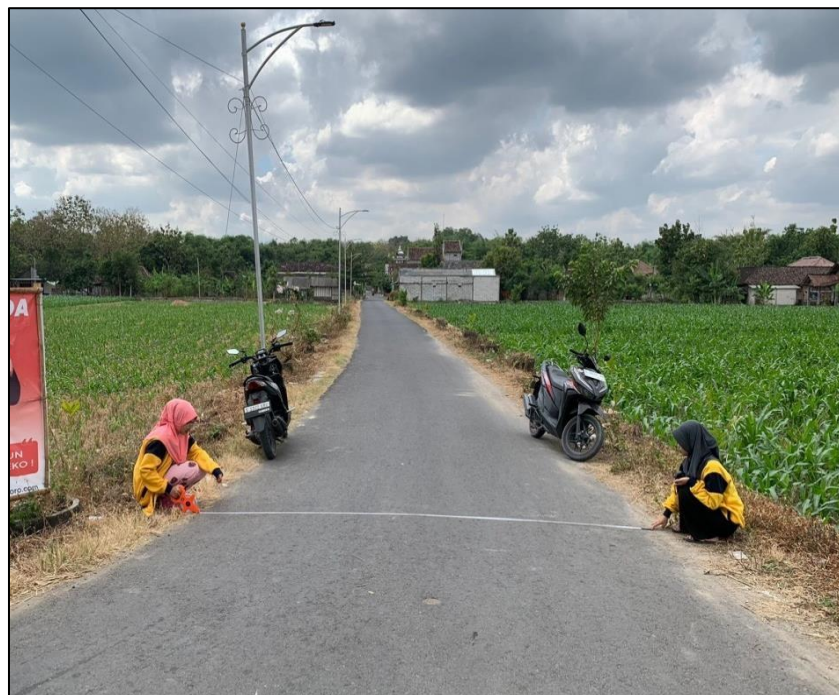
Gambar 3. 15 Survei Bangunan Eksisting Jalan Aspal Desa Butoh
