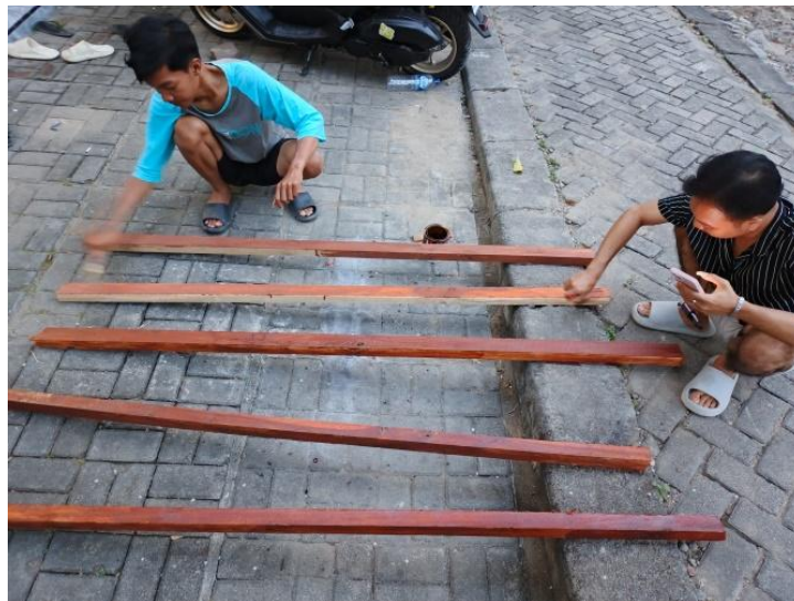
Gambar 3. 42 Pengecatan kayu dengan Plitur
