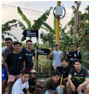
Gambar 6 Pemasangan papan petunjuk jalan
