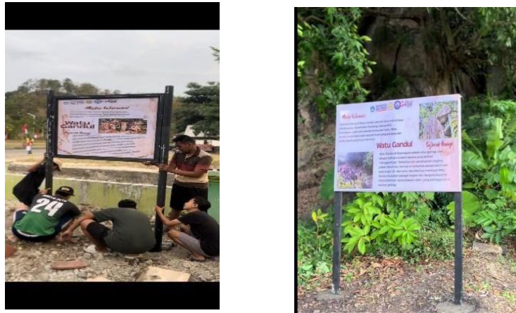
Gambar 5 Pemasangan papan informasi
