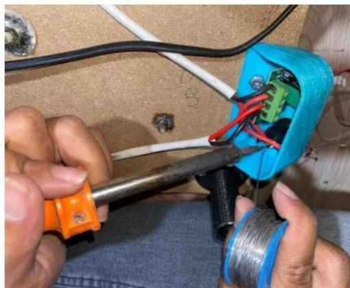
Gambar 4. 5 Perakitan komponen switch
