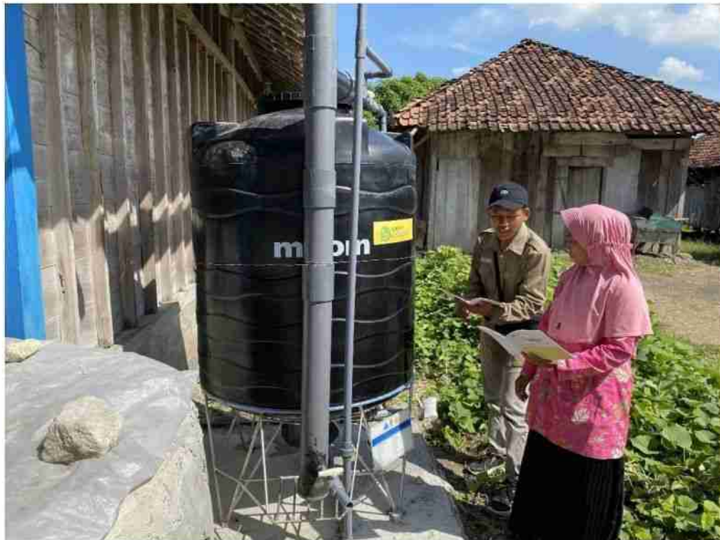
Gambar 5. 2 Demonstrasi dan Pendampingan Penggunaan Instalasi Pemanenan Air Hujan (IPAH)
